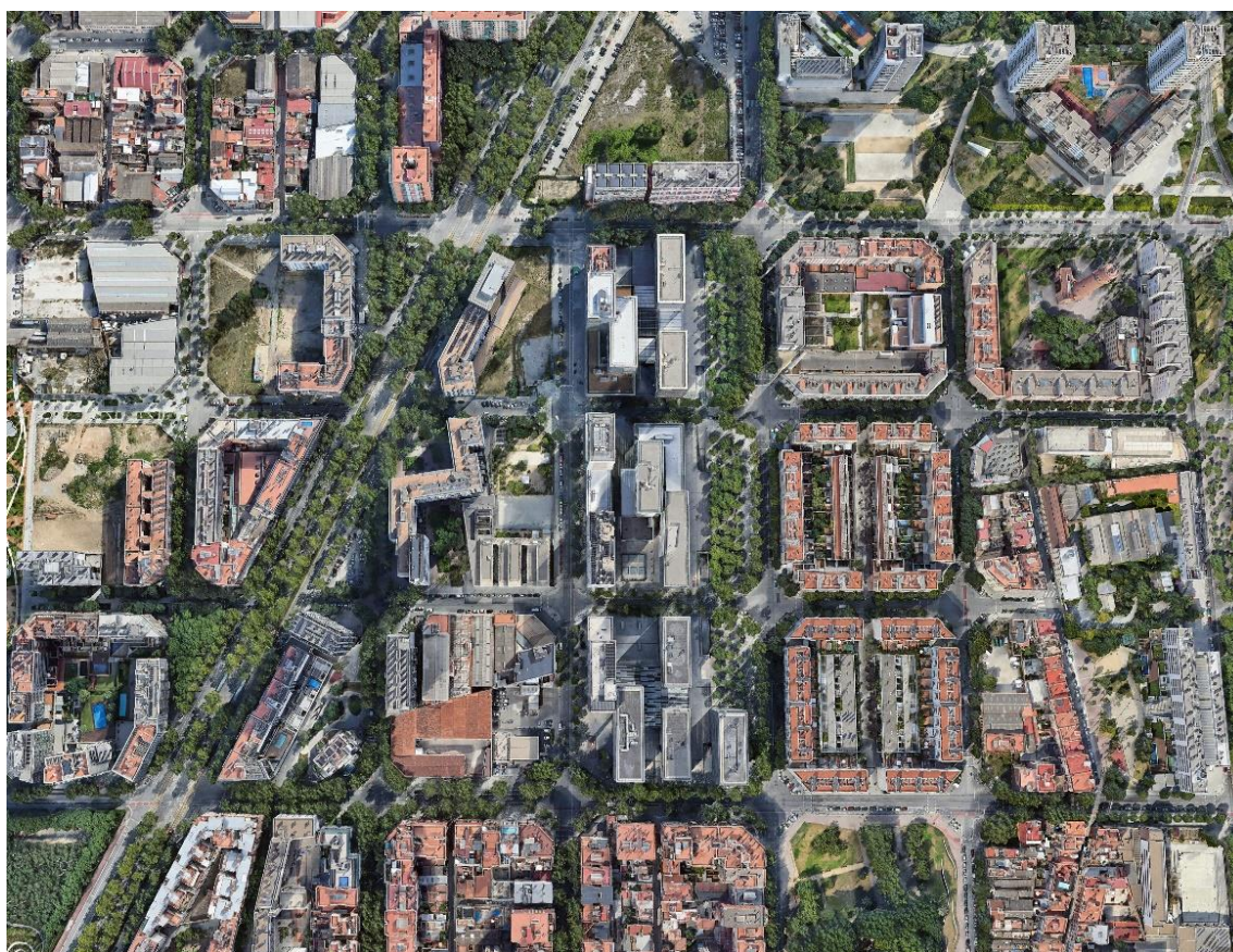
FIGURA 1.9 | 22@BARCELONA, BARCELONA, ESPANHA
