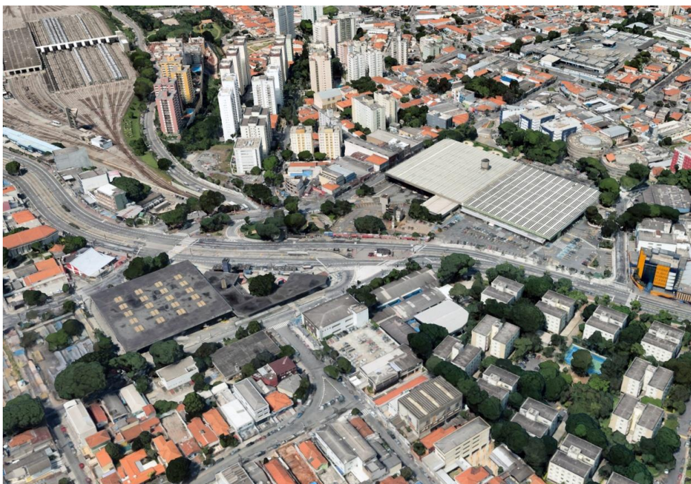
FIGURA 2.9 | SITUAÇÃO URBANA ATUAL DO ENTORNO DA ESTAÇÃO JABAQUARA
